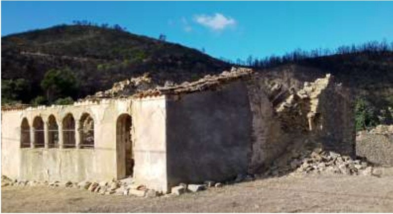
الوثيقة رقم 20: صورة توضيحية للواجهة الجانبية الشمالية للزاوية (المصدر الباحث، 2021/10/8)
