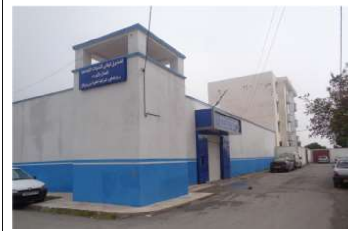
الوثيقة رقم (36): صورة للواجهة الشمالية الغربية للقسم بعد إعادة تهيئة كمقر للفرع المحلي لصندوق الضمان الاجتماعي للجراء وغير الاجراء، المصدر: الباحث، 2017
