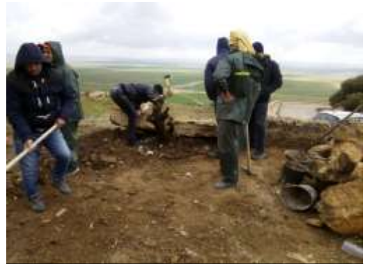
الصورة رقم 09: عملية تنظيف الموقع
