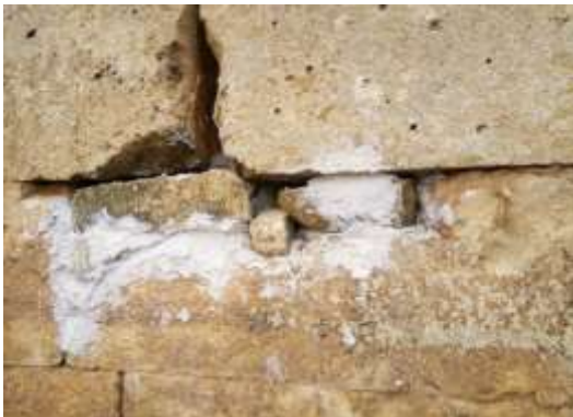
الصورة رقم 18: عملية سد الفراغات الموجودة بالجدران
