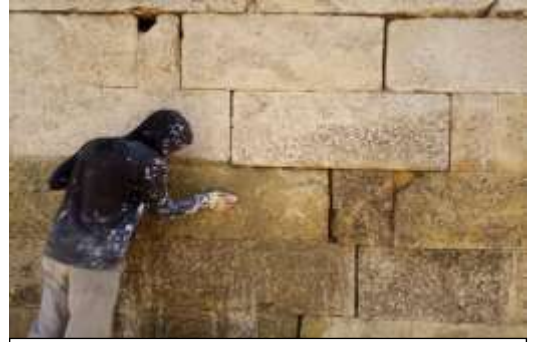
الصورة رقم 21: تنظيف الجدران بالماء و الفرشاة
