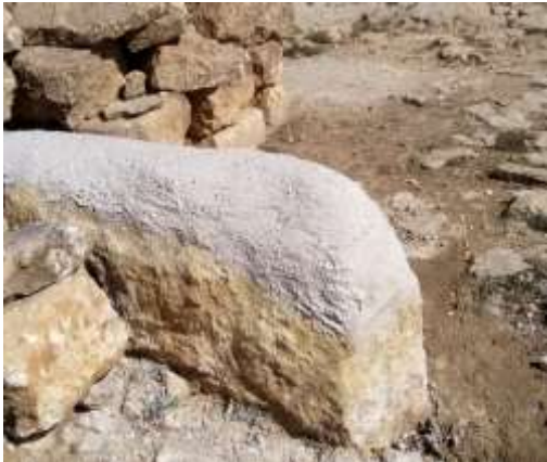
الصورة رقم 26: شكل الحجارة بعد نهاية الترميم
