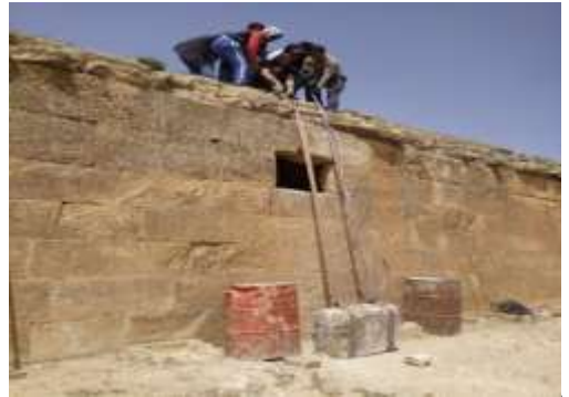
الصورة رقم 13: عملية رفع الحجارة بواسطة الحبال
