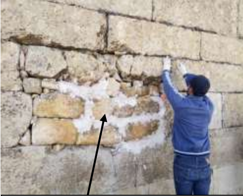
الصورة رقم 28: ملئ الفجوة الموجودة بالواجهة الغربية
