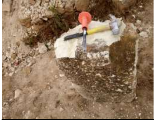
الصورة رقم 15: عملية صقل الحجارة بالمطرقة و
