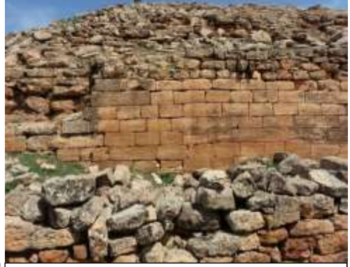
الصورة رقم 04: الواجهة الجنوبية لمعلم الكسكاس
