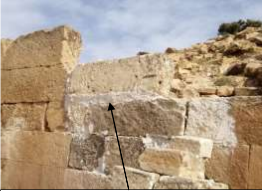
الصورة رقم 32: اعادة بناء الاجزاء الناقصة بالواجهة
