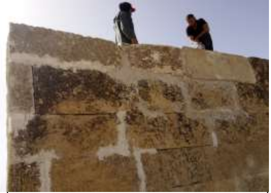
الصورة رقم 19: عملية اعادة بناء الحجارة المتساقطة
