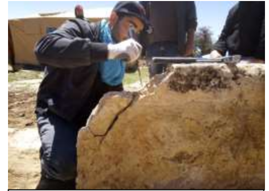
الصورة رقم 23: تبين تنظيف الحجارة قبل ترميمها
