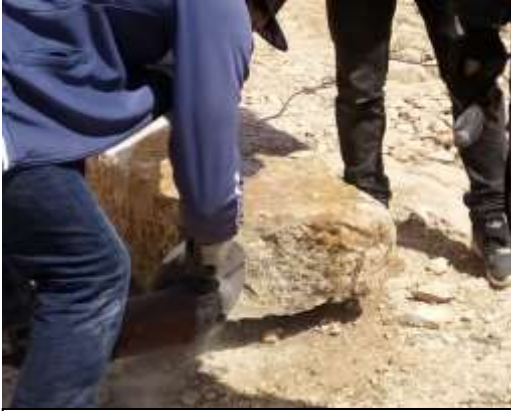
ال صورة رقم 16: عملية صقل الحجارة بالقاطعة الكهربائية
