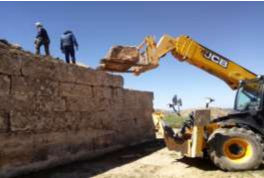
الصورة رقم 14: عملية رفع الحجارة بواسطة الرافعة
