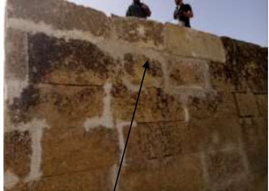
الصورة رقم 31: اعادة بناء الأجزاء الناقصة بالواجهة الشرقية
