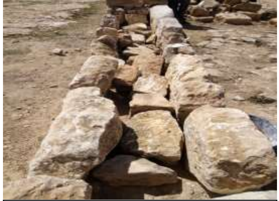
الصورة رقم 27: استكمال السور الخارجي للواجهة الجنوبية
