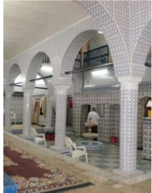
الصورة 3: الغرفة الباردة
