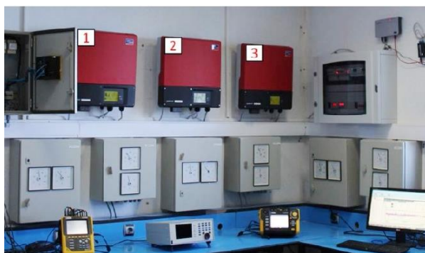
Fig. 3: Installation des onduleurs photovoltaïques au niveau du laboratoire
