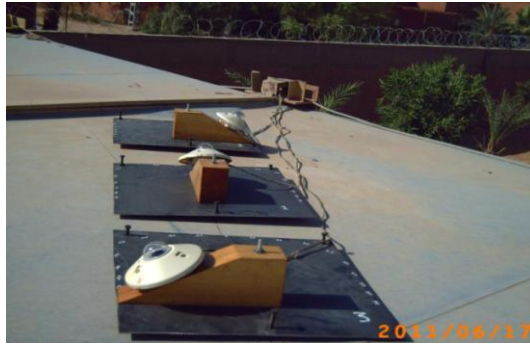
Fig. 4: Photo montrant l'installation des trois pyranomètres installés sur une cabine saharienne à Adrar
