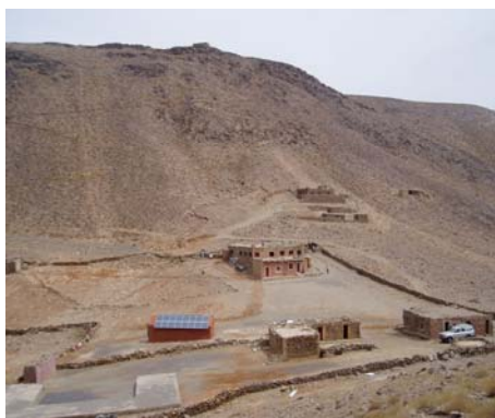
Fig. 6: Vue générale sur les bâtisses du refuge de l'Assekrem
