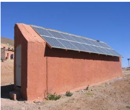
Fig. 2: Générateur PV, formant en même temps le toit de l'abri technique
