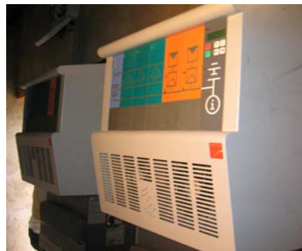
Fig. 3: Vue de l'onduleur (fond) et vue de la centrale de gestion et de régulation (avant)
