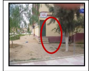
الصورة رقم (06) : فتح أبواب في الطوابق الأرضية للعمارات بحي 1000 مسكن
