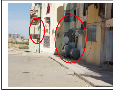
الصورة رقم (04) : تموضع خزانات المياه والهوائيات المقعرة بحي 400 مسكن المصدر: تصوير الباحث
