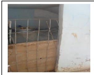
الصورة رقم (07) : إستعمال الصهاريج تحت قفص السلم
