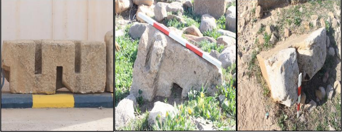
الصورة 08: عناصر معمارية لمعصرة (تصوير الباحثة)
