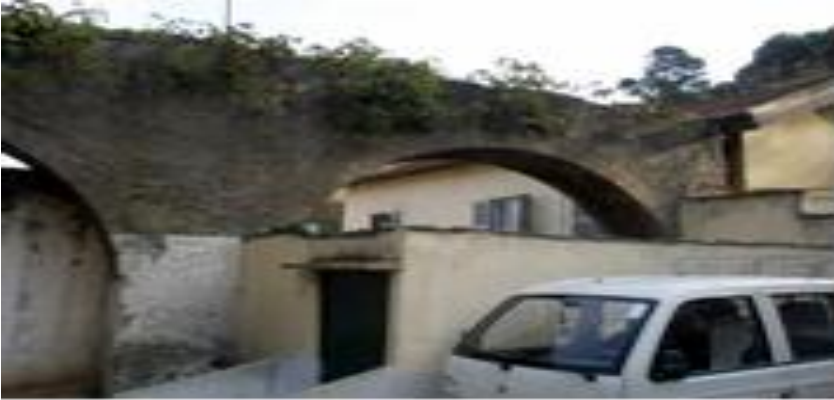
Fig. 6. Vestiges de l'aqueduc de Birmandreis situés en amont de la rue de l'Oued Kniss, mai 2010 (clichés auteure)
