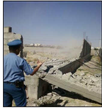
الصورة رقم (1): تبيان عملية تنفيذ قرار هدم سنة 2011 المصدر: لجنة مكافحة البناء الفوضوي لبلدية بئر العاتر 2016
