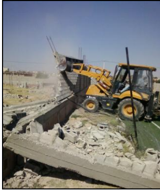
الصورة رقم (2): تبيان عملية تنفيذ قرار هدم سنة 2011 المصدر: لجنة مكافحة البناء الفوضوي لبلدية بئر العاتر 2016
