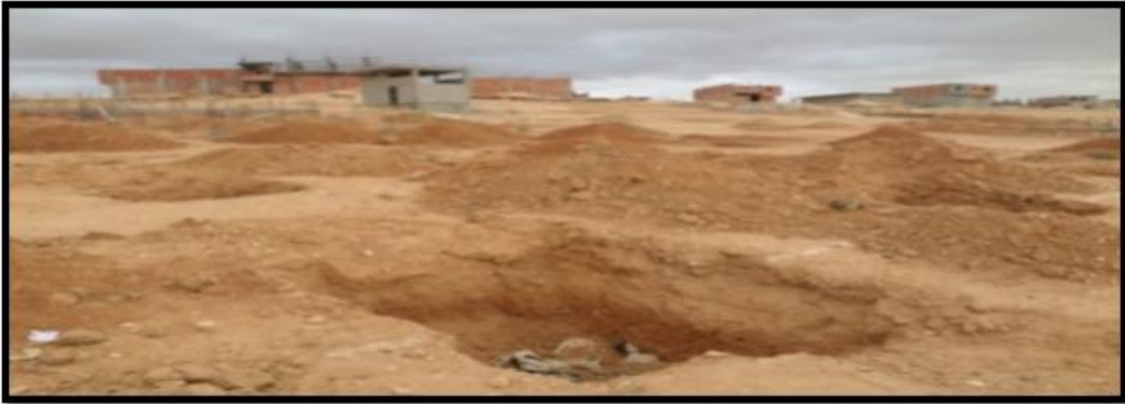
Photo N°( 05 ) : Où nous avons remarqué la présence d'œuvres modernes représentées dans les structures chaotiques et les surfaces et parties de colonnes et d'arpentage et de calage Terrain avec un cou de 110 trône à l'ouest de la route aménagée.
