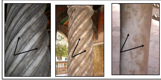
الصور رقم 09 : مختلف تغيرات الألوان على الأعمدة الرخامية بقصر احمد باي بقسنطينة
