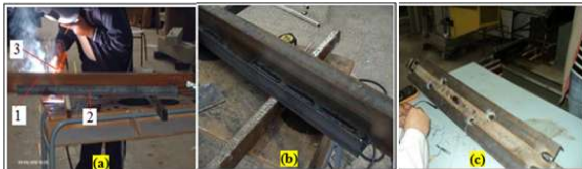
Figure 3. Opérations de soudure
