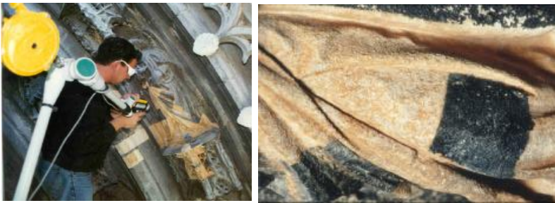
الصورة رقم 4، 5: استعمال تقنية الليزر (تنظيف حراري)
