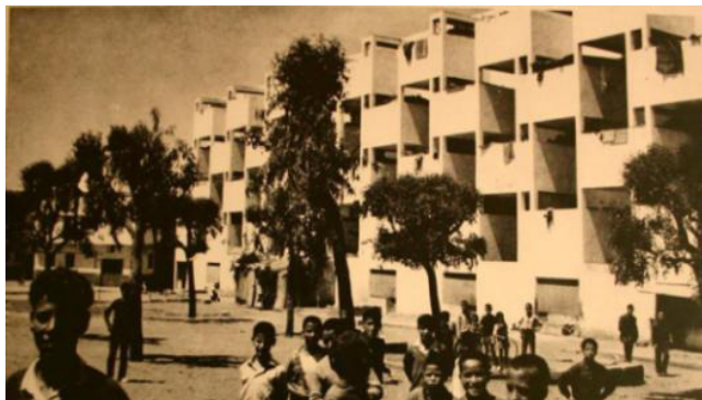
Figure N° 2. Immeuble « Nid d'abeille » à Casablanca, 1952 (Candilis, Woods architectes).
