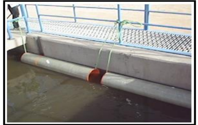
Figure 01. Conserver les conduites en PRV à l'eau usée de Ouargla.
