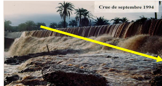
Figure 5. Débordement du Barrage de rétention de Oued Ntissa.
