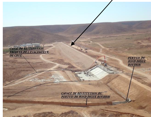
Figure 24. La digue de Boubrik de Oued Ghrazil réalisées en 2007.
