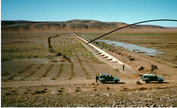
Figure 22. Digue de Oued Haimeur réalisée en 2004.
