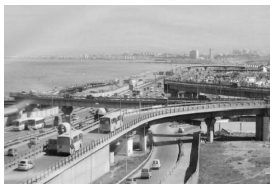
Figure 4: Échangeur El-Annasser à Alger. Déqualification du paysage par les voies rapides
