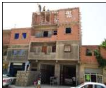
Figure3 : Le premier étage occupé, le deuxième en chantier et la quatrième dalle en cours d'exécution. Notons le propriétaire en train de faire monter le corps creux.
