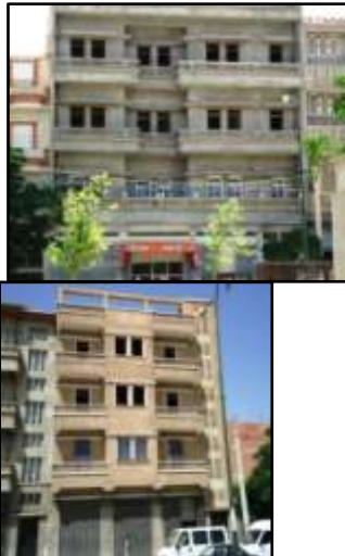
Figure 2 : Seul le premier étage est occupé, les deux autres en cours et les façades à un stade très avancé de finition.
