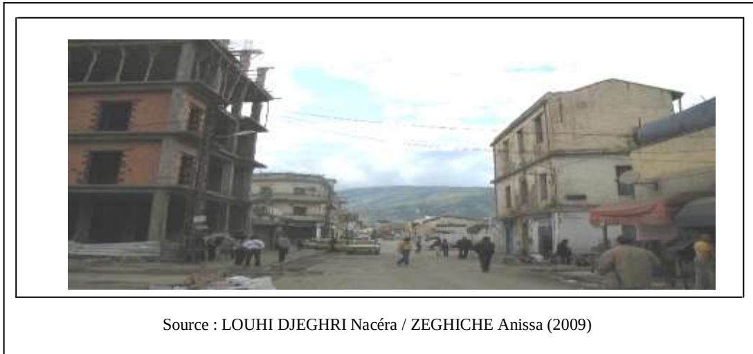
Photo 3 : Centre-ville d'Annaba, Boulevard Souidani Boudjemaa -Obsolescence du bâti-
