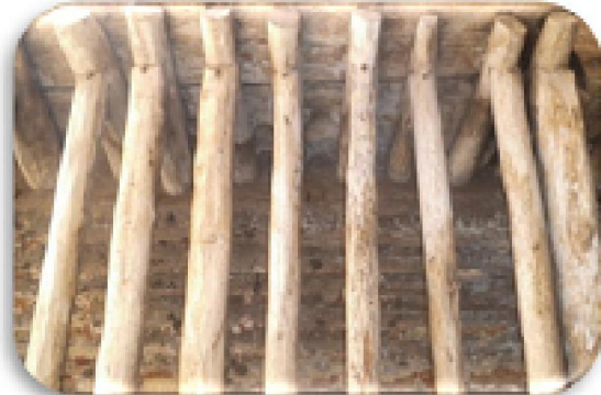
ظاهرة التغير اللوني بسبب الضوء الطبيعي الذي أدى إلى اصفرار الخشب وضعفه بسبب تحلل الألياف الناتج عن تأثير الأشعة فوق البنفسجية
