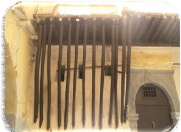
ظاهرة الالتواء بخشب تسقيف متعرض لضغط موازي للألياف
