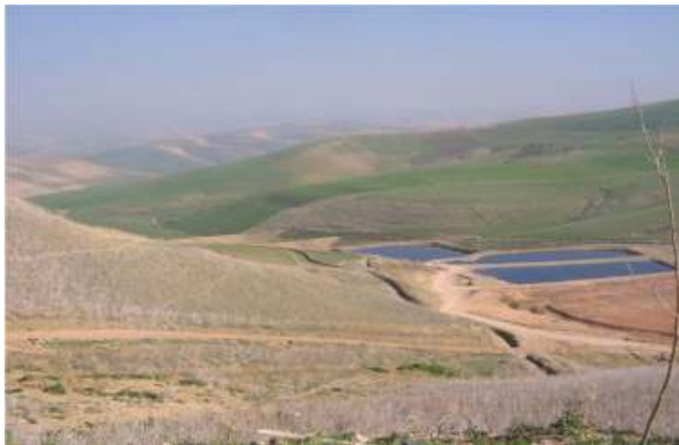
Photo 1. Décharge publique contrôlée de la ville de Fès
