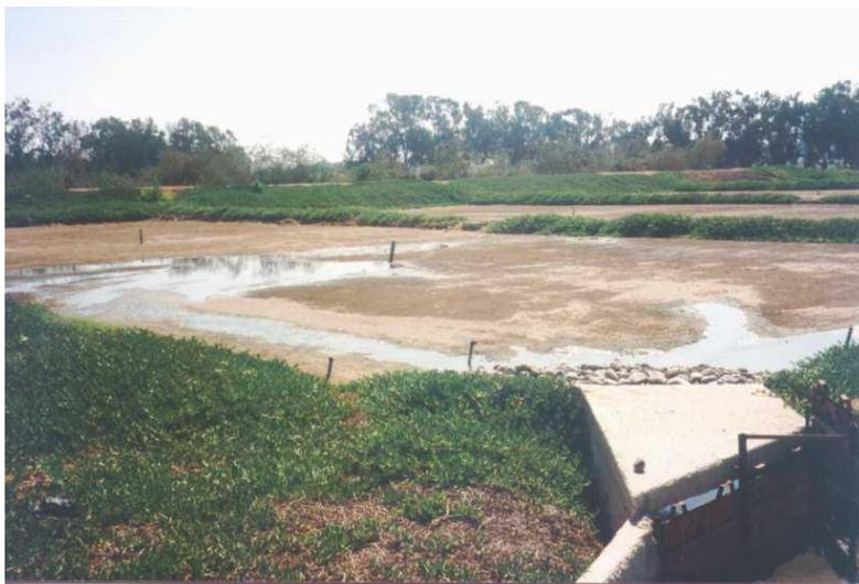
Fig.2. Station de Ben Sergao, traitement secondaire des eaux usées domestiques de la ville d'Agadir (Maroc) par infiltration-percolation
