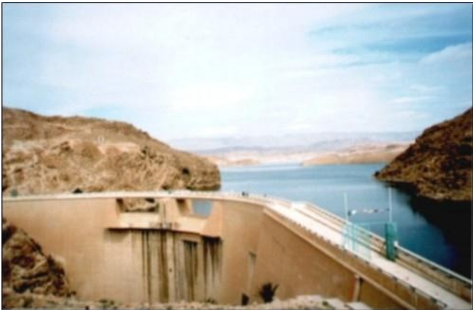
Photo1 : Vue générale du barrage de Foum-El-Gherza, Biskra, Algérie [1]
