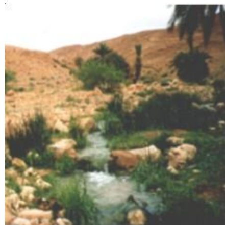
Photo 3 Fuites d'eau au niveau de la résurgence n°14 avec un Q_f=10 l/s
