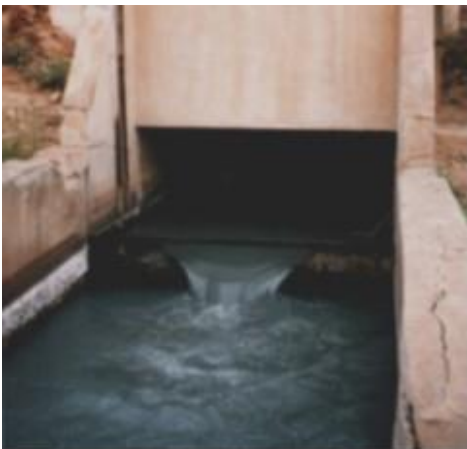
Photo 2 Canal d'amenée des débits de fuites Équipé d'un seuil triangulaire Q_f=140 l/s
