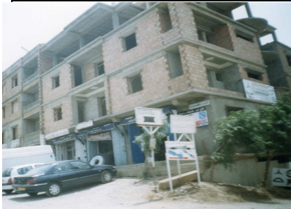
الصورة رقم: 6 بنايات شيدت فوق أرض زراعية ببرج الكيفان التقطت هذه الصور بتاريخ 12 أوت 2011
