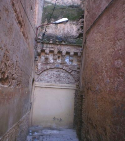
الصورة4: باب مصمت في درب غير نافذ بتلمسان، لاحظ أن شواهد الباب لا تزال ظاهرة، وبهذا أصبحت هذه الجهة ظهر المسكن، ويمكن لصاحبها إعادة فتح بابه مرة أخرى .
