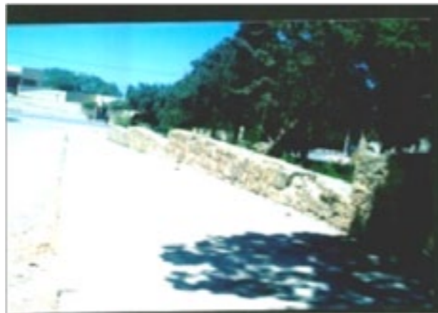
Fig. 5. Enceinte française : tronçon Sud-Est.
