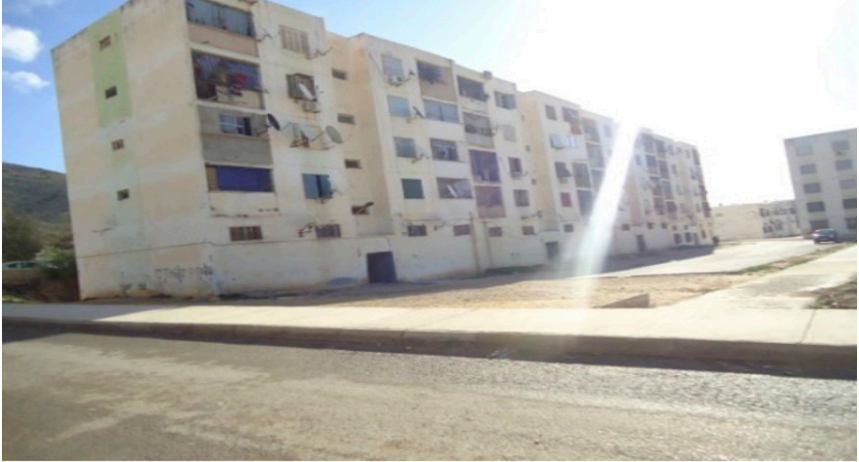
Figure N° 10 : Fermeture du séchoir et du balcon par une véranda
