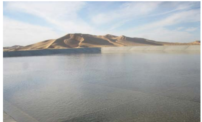
Image.2 Bassin N°01 en cours de Remplissage
