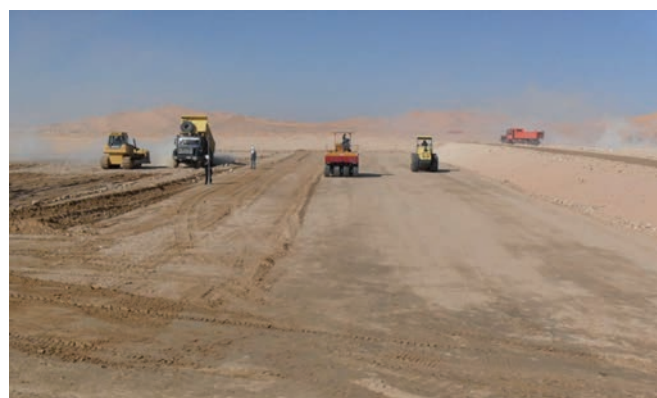
Image.1 Travaux de terrassement et de compactage.
