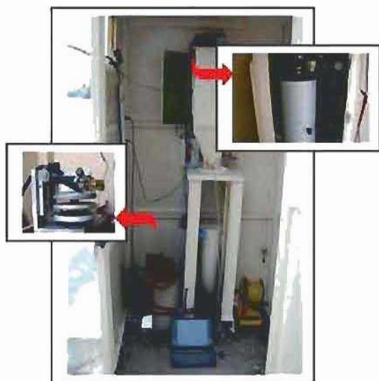
Fig. 1 Site marégraphique d'Alger abritant les deux marégraphes électronique et analogique.
