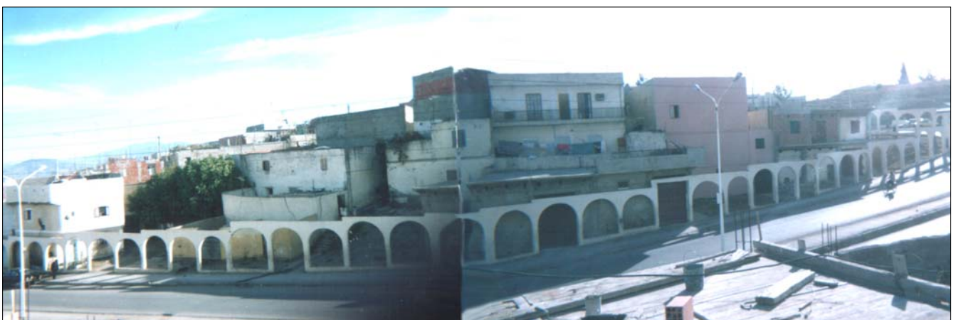
Photo 2 : Oued Skhoun rive droite ; le mur-arcades longeant le quartier
