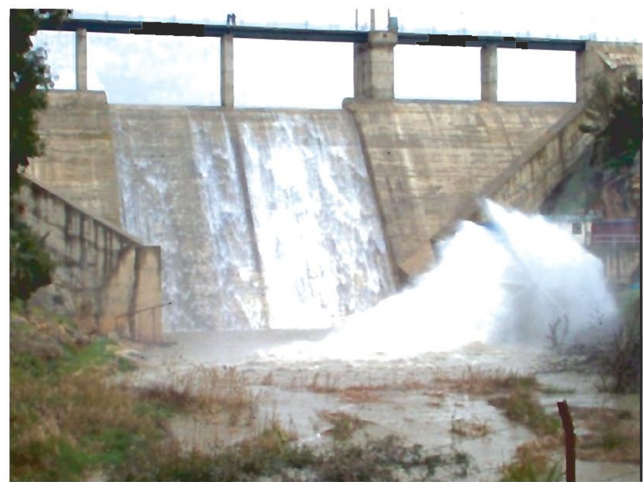
Photo. 2 (ANBT, 11 avril 2005) Vue aval et déversement de crue du barrage de Hammam Grouz
