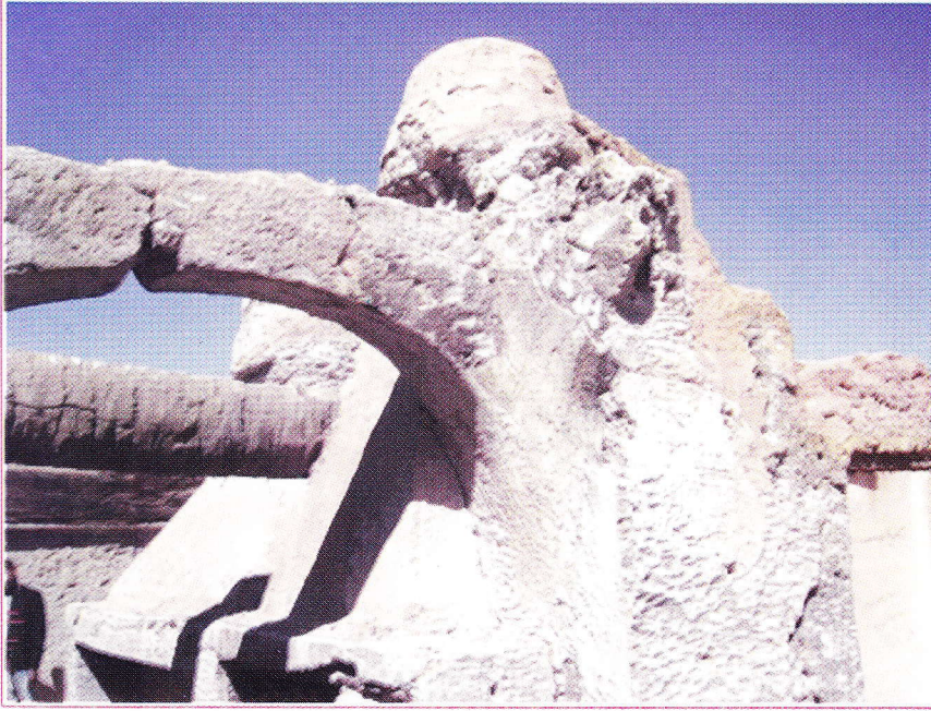
صورة 7: جذوع النخيل المستعملة في التسقيف.
