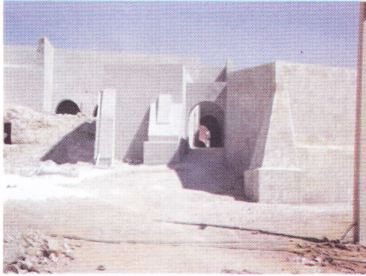
صورة 4: طريقة التلبيس بعد حرقها وطحنها ( قديما وحدينا )
