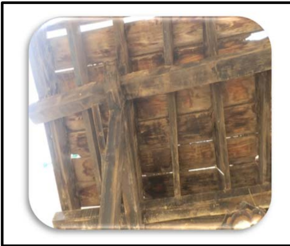
صورة 8 وجود كسور وانفصالات للعوارض والروافد والالياف ناتج عن تلوث البيئة عن الطالب
