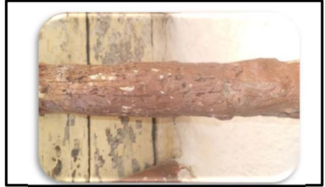
صورة 5 شروخ وانفصالات منها ما هو متسع عميق والبعض دقيق سطحي على طول الرافدة الخشبية ناتج عن تأثير درجات الحرارة لفترة طويلة عن الطالب
