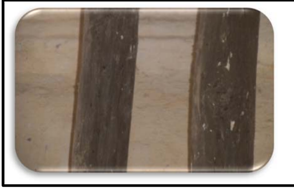
صورة 12 ظاهرة انكماش روافد تسقيف نتيجة جفاف الخشب عن الطالب
