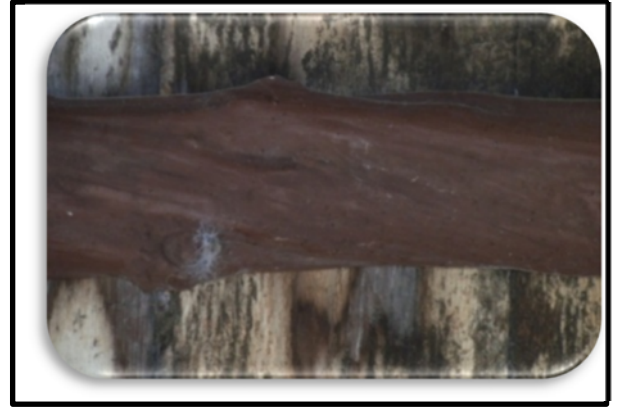
صورة 9 تآكل للعقد بسبب ظاهرة التسوس والإصابات الحشرية عن الطالب
