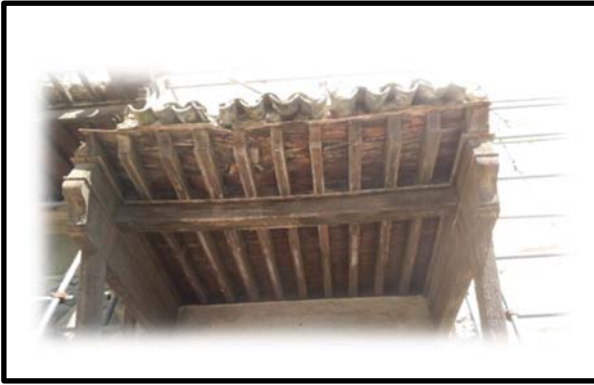
صورة 6 طبقة سوداء ناتجة عن غازات التلوث الجوي عن الطالب
