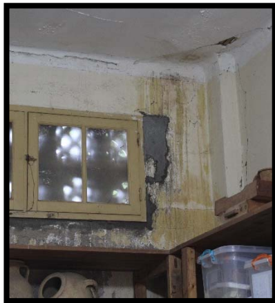
الصورة رقم 11: تبين دخول وتأثير الأمطار على المخزن 1
