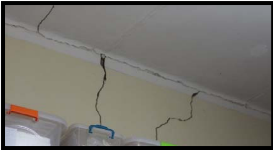
الصورتين رقم 9/8: تبينان درجة التشققات والكسور لجدران وسقف المخزن 1
