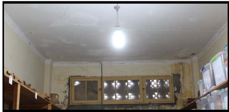
الصورتين رقم 9/8: تبينان درجة التشققات والكسور لجدران وسقف المخزن 1
