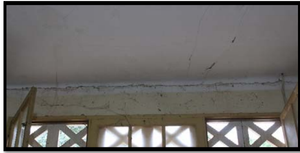
الصورتين رقم 9/8: تبينان درجة التشققات والكسور لجدران وسقف المخزن 1
