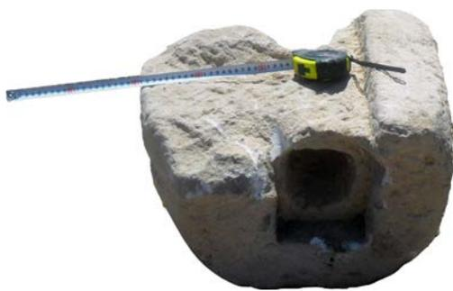
**Fig. 14:** Une conduite des eaux pluviales encastree en pierre de taille. HADJI, Y-R., Octobre 2013.
