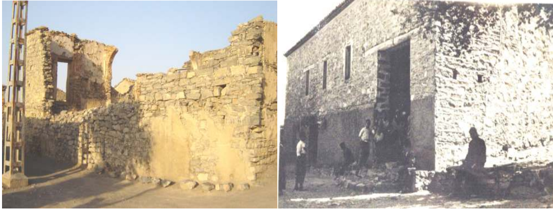
صورة رقم (08 و 09): الواجهة الخلفية لجامع بومرزوق الحالية/ نفس الواجهة قبل عام 1948م والسقيفة الضخمة المهتمة حاليا .
