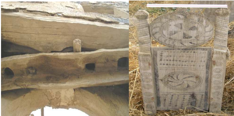
صورة رقم (16): نظام العتب الخشبي العلوي / صورة رقم (17): شاهد قبر خشبي موجود ببيت صلاة بياحدي مداخل بيت صلاة أحمد أوطالب. مسجد أحمد أوطالب.
