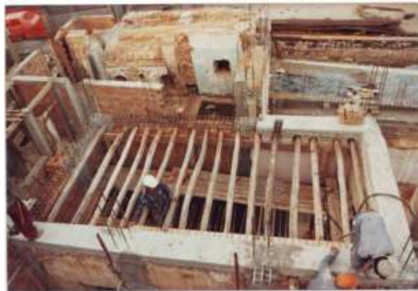
Figure n° 5: Les travaux de restauration.
