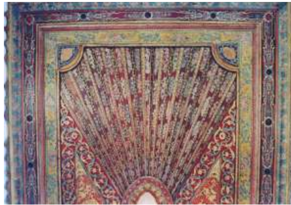
Figure n° 6: Détails ornementaux du plafond de la Salle à manger (A) Après la restauration
