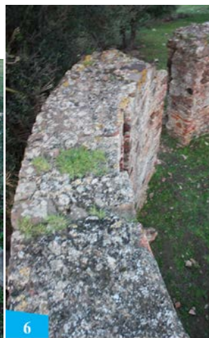
Epaisseur du mur
