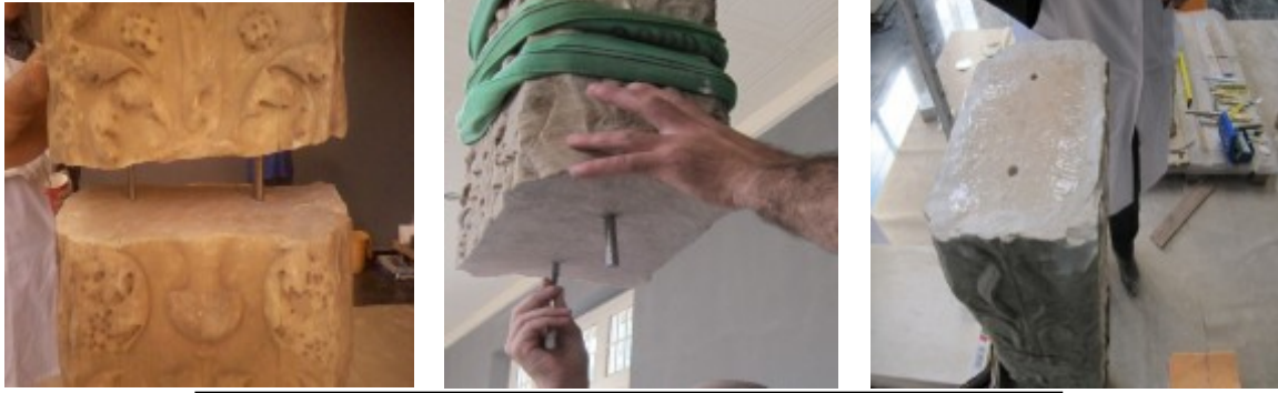
صورة رقم 08: عمليات ترميم عمود تزييني
