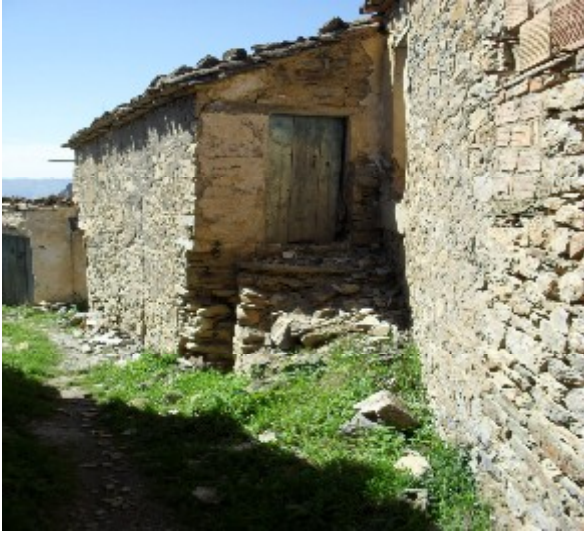
صورة رقم(10): الواجهة الشمالية
