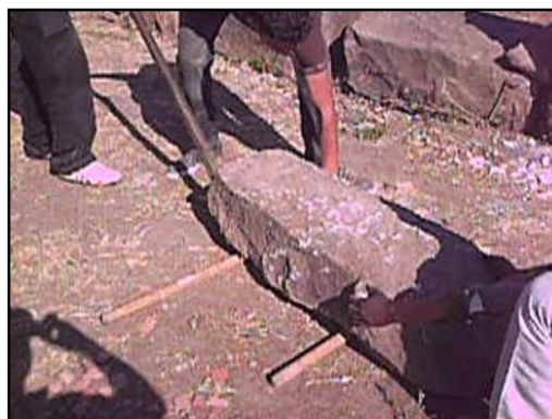
Photo n° 12 : Technique de déplacement des grosses pierres.
