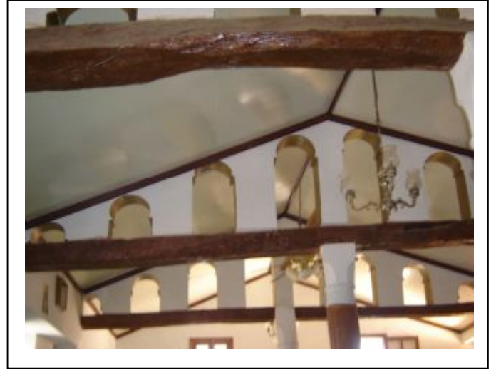
صورة 09: طريقة تسقيف جامع صدوق العلوي
