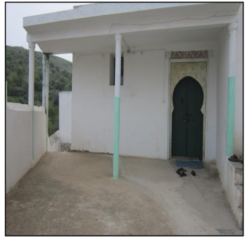
الصورة 04: مدخل وسقيفة مسجد مولاي إدريس
