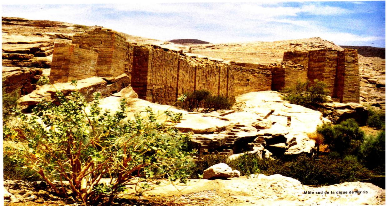
ج/ سد مأرب القسم الجنوبي ، بقايا آثار السد منذ الألف 1 ق. م . Pierre Gentell , la Maîtrise De L'irrigation , Y. P. R. S , P. 76 .
