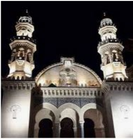
مسجد كتشاوة العثماني بعد ترميمه وتدشينه عام 2018م (19)
