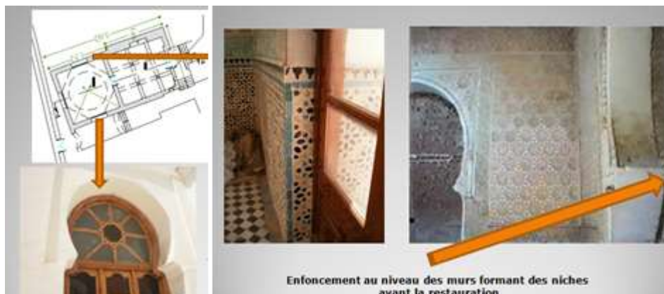
Fig.10 : Transformation des niches intérieures en ouverture de grande dimension
