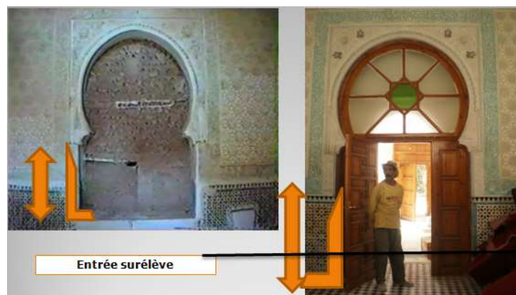
Fig.08 et 09 : Avant et après restauration de la portée d'entrée
