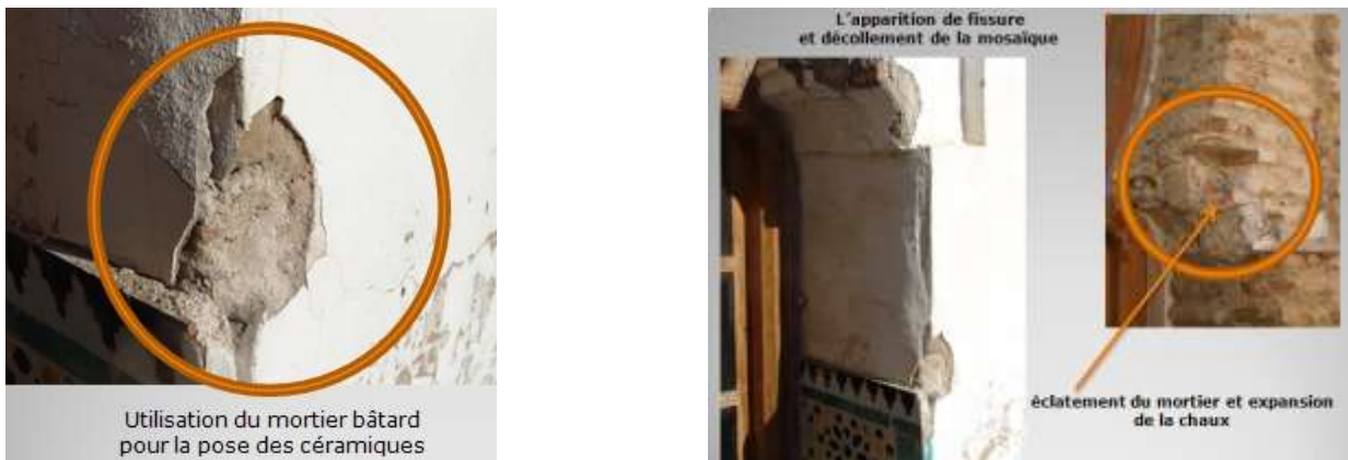
Fig.12 : Incompatibilité des matériaux utilisés
