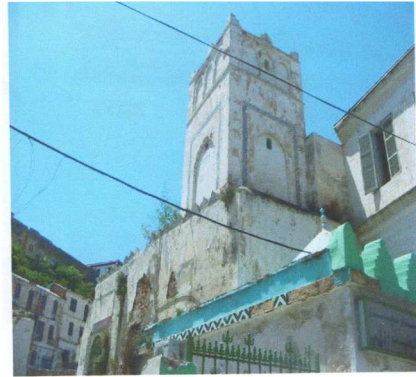
الصورة رقم 05: الواجهة الرئيسية لجامع سيدي الهواري
