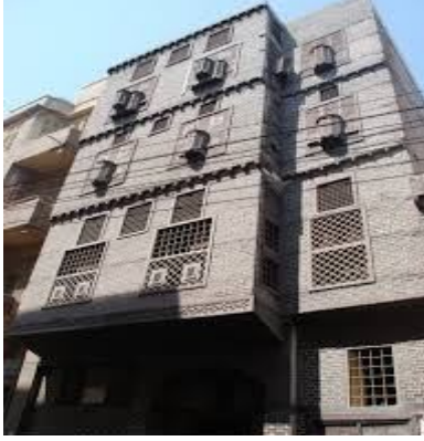
شكل 3: واجهة منزل القنادلي
