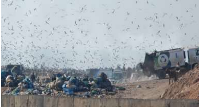
Figure 6 : La décharge de Médiouna vue de l'extérieur 15
